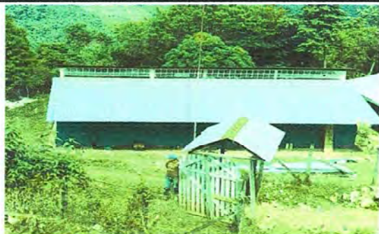
Foto1: Cubierta de laminas nuevas
