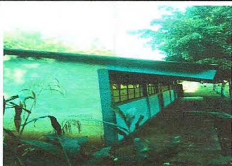
Foto 3: Mantenimiento de piso
