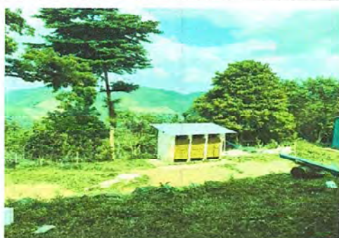
Foto 5: Sustitucion de cubierta de laminas
