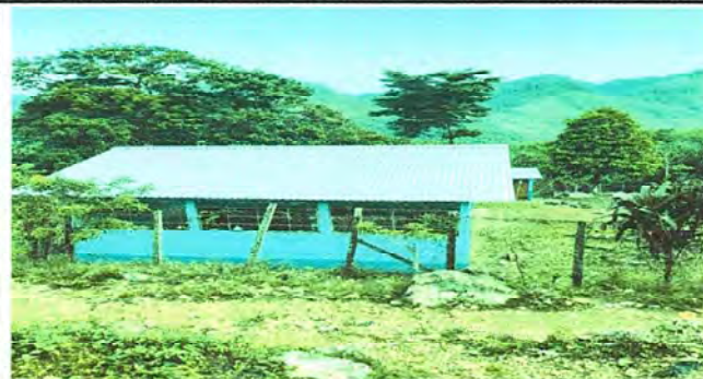
Foto 2: Pintura nuevas en muros
